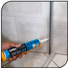
Box de Banheiro
